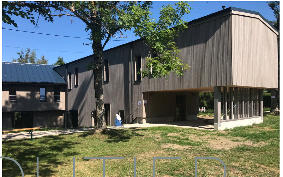
Vue de l'extension en porte-à-faux
